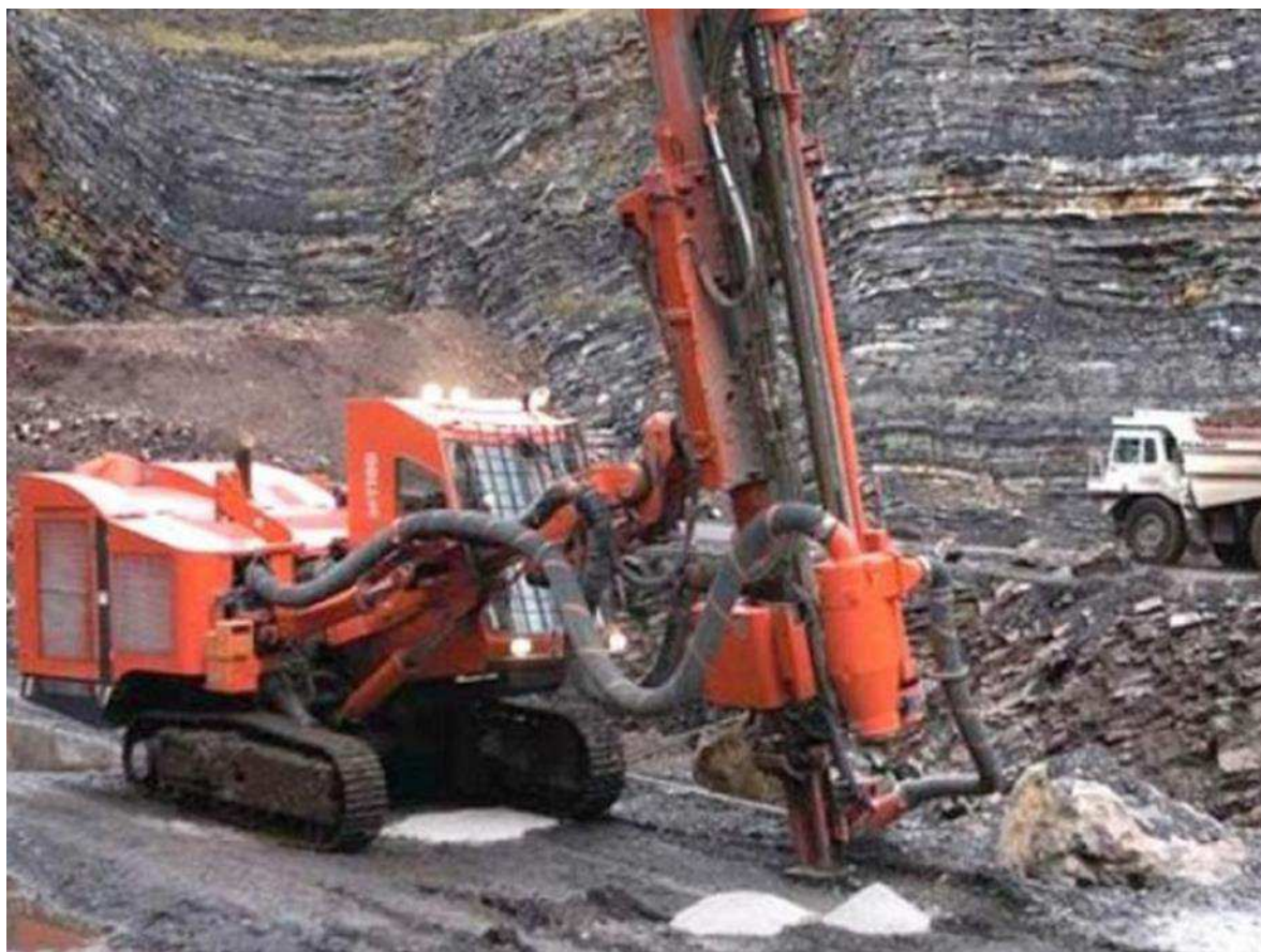
Рисунок 2.10 — Установка для бурения скважин
